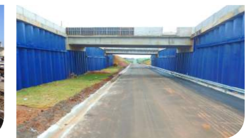
Trincheira (DNIT) Local: Tuneiras do Oeste, PR Produtos: AZ®17-700 e AZ®19-700
