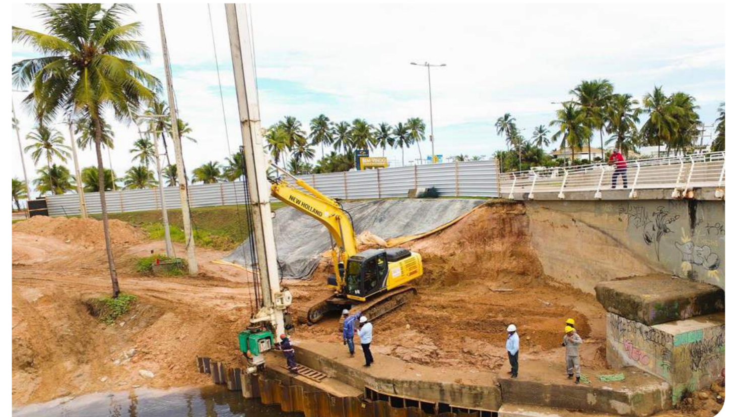
Ponte do Paiva Local: Recife, PE Produtos: GU™ 6N
