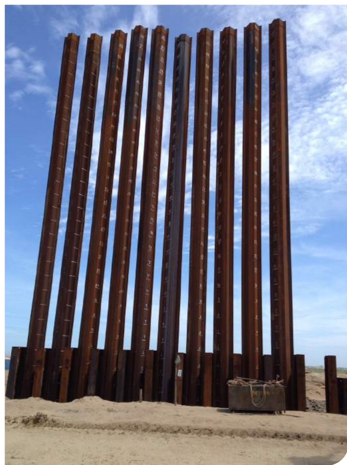
Terminal BPort Local: Porto do Açu, RJ
