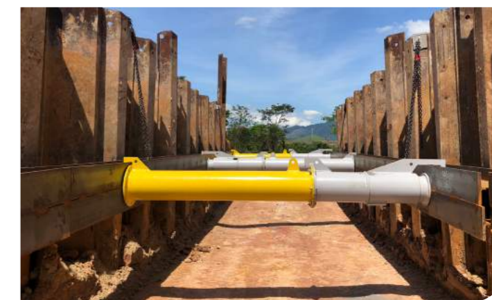
Escoramento de Vala Comperj
