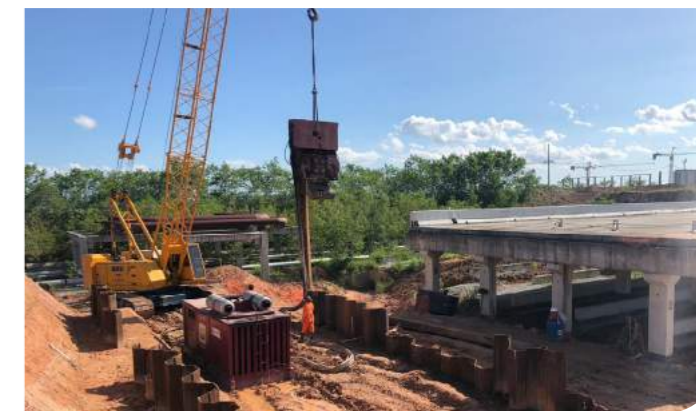
Escoramento de Vala Comperj Local: Itaboraí, RJ Produtos: AU™ 14, GU™ 13N, GU™ 14N, AZ® 17-700, AZ® 19-700, AZ® 26-700
