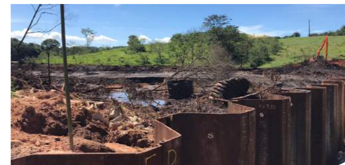
Contenção de Rejeitos Local: Brumadinho, MG Produto: AZ® 19-700
