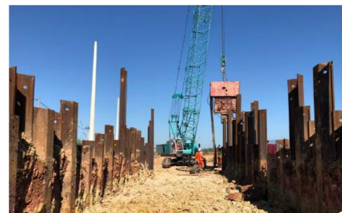
Escoramento de Vala Comperj
