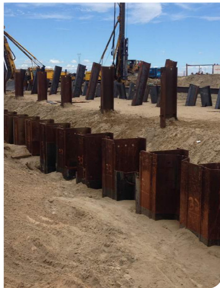
Terminal BPort Local: Porto do Açu, RJ
